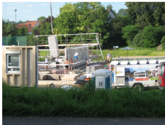
Wir beobachten eine Baustelle
